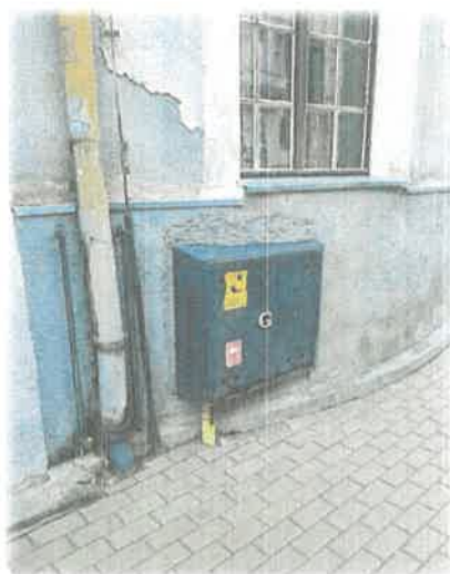
Zdjęcie. 1. Widok na kurek główny instalacji gazowej zlokalizowany na ścianie budynku ośrodka od strony ul. Wojska Polskiego.
